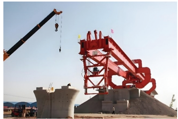
图4 架桥机工作现场
