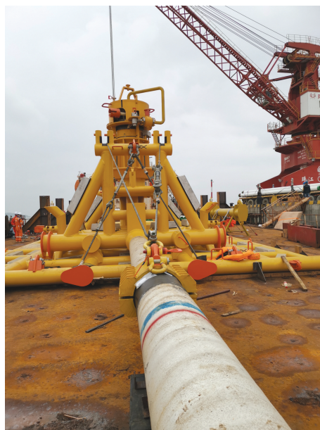
图 16 南海陵水气田冲洗压力帽现场安装情况
