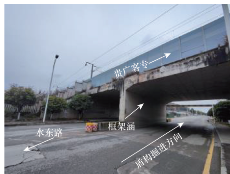
图7 盾构隧道穿越框架涵地表
