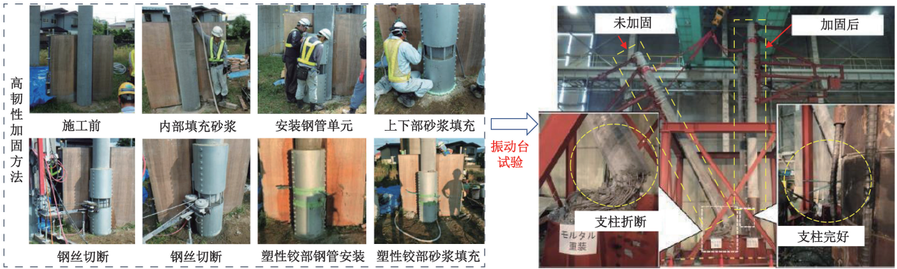
图8 文献[50,91]中提到的高韧性加固方案
