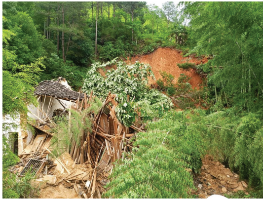
图 1 滑坡隐患坡体地形图及现场图
