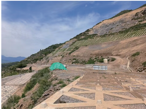
图5 立节北山滑坡治理措施
