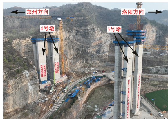
(b) 现场施工图
