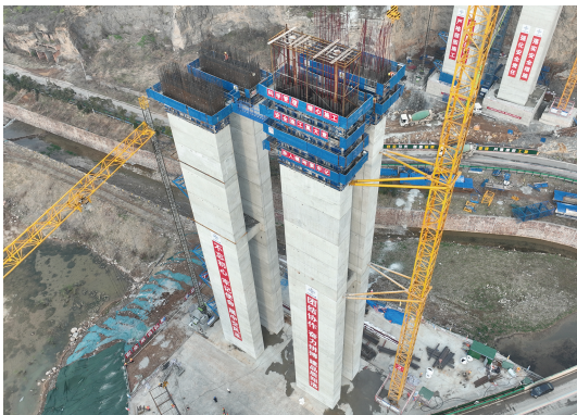
图 17 5 号双肢高墩施工图
