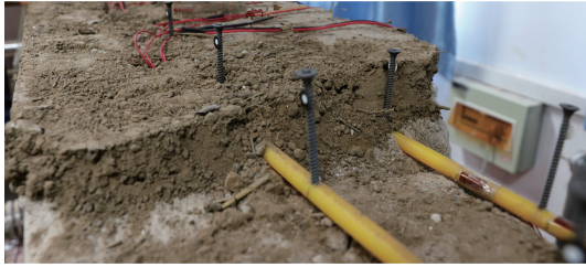
图 3 管道铺设情况
