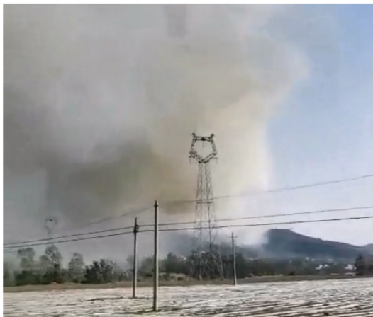
图8 山西省天镇县火点现场情况
