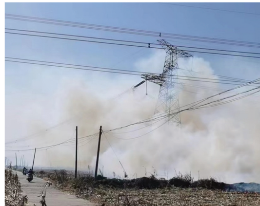
图 13 山西省朔城区火点现场情况
