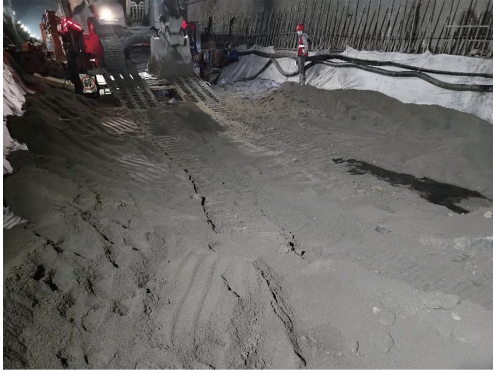
图 15 已衬砌段底板保护施工现场
