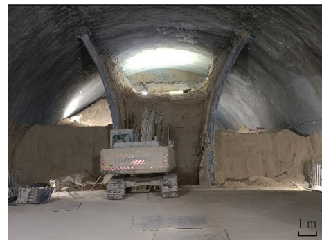
(a) 邵家塘隧道左线断面开挖现场图
