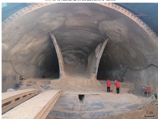
(b) 邵家塘隧道测点布置现场
