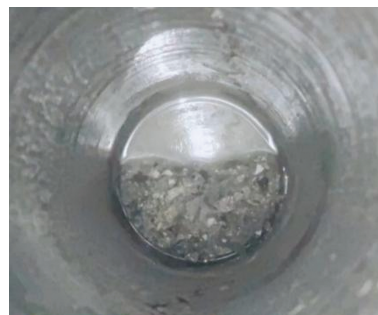
图4 现场钻孔取芯试验
