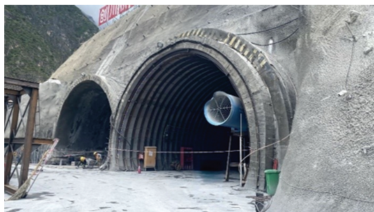
图1 黄角坪隧道工程
