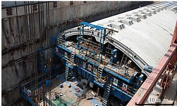
图 1 双丰地铁站现场施工图
