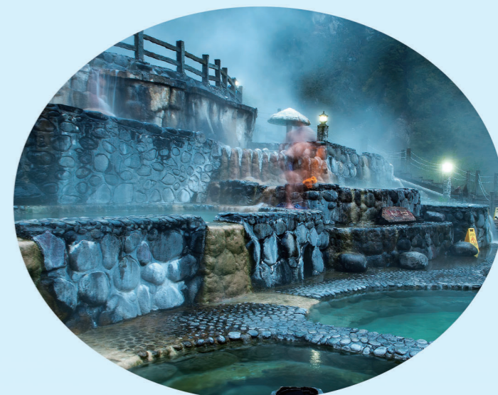
四川甘孜海螺沟温泉 ▲四川甘孜海螺沟温泉
