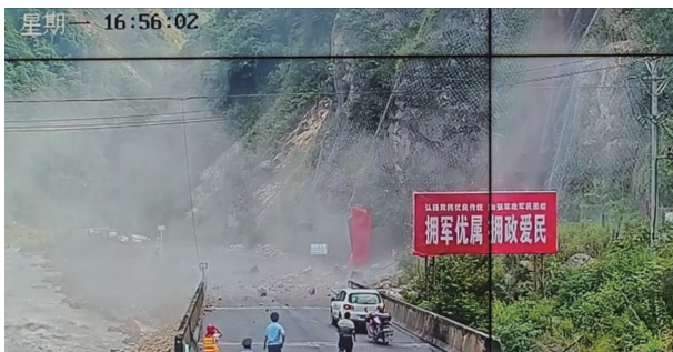
图 6 危岩崩塌后落石停积位置
