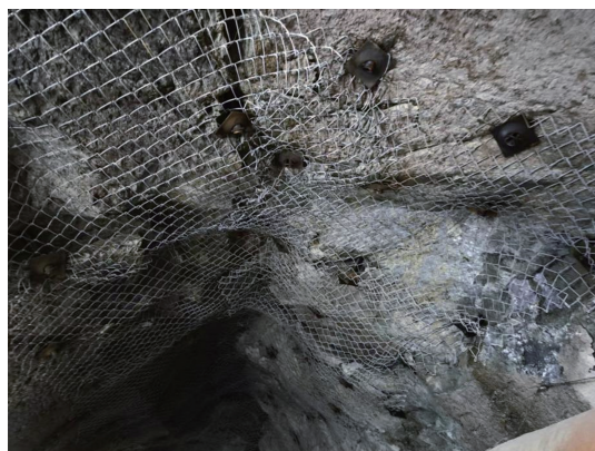
图 7 锚网喷支护的施工现场
