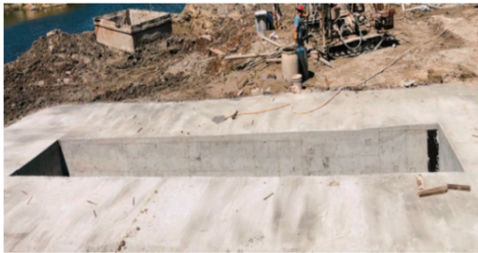
图 14 导槽与导墙布置、导槽施作示意图
