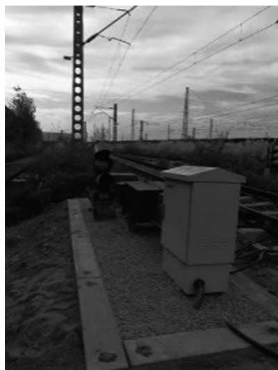
图5 袁树林站室外改造现场
