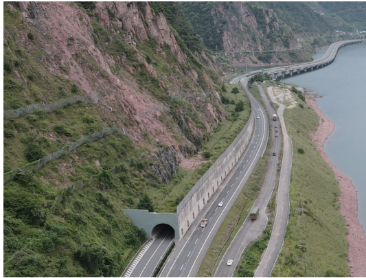
图8 治理后运行情况
