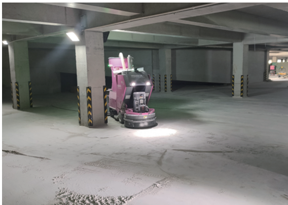
(a) 地坪研磨机器人施工
