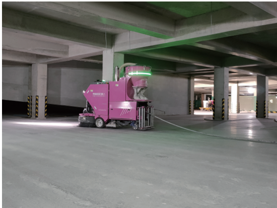
(a) 在地下车库场景中的施工应用
