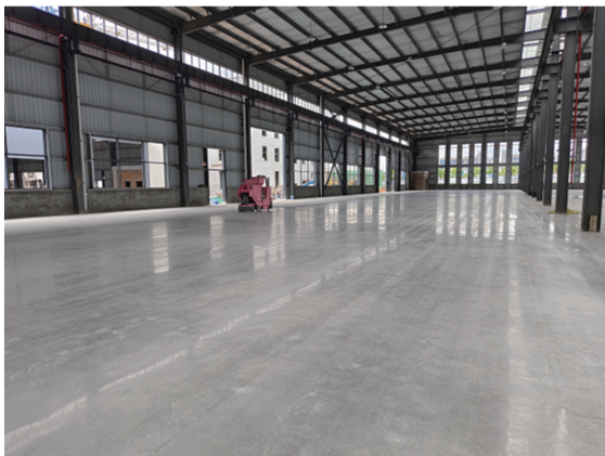
(b) 在钢结构厂房场景中的施工应用
