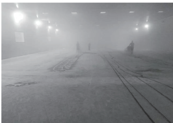
(b) 传统人工研磨设备施工
