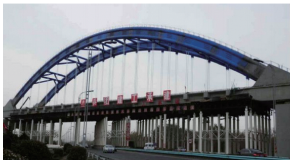
图 1 1-128 m 系杆拱桥现场
