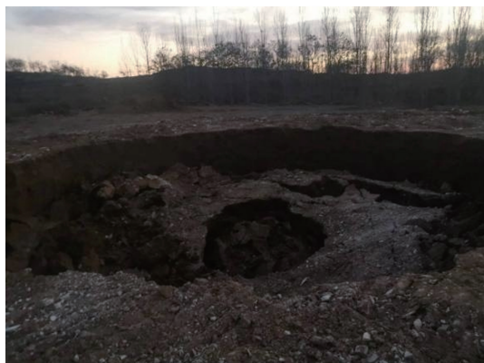
(b) 隧洞出口处地面涌水塌陷
