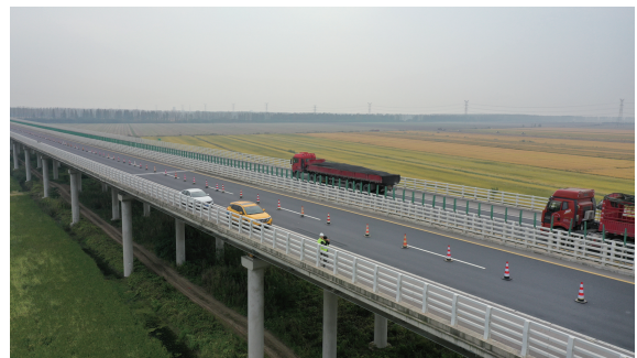
图 1 寿春淮河特大桥堤外引桥现场
