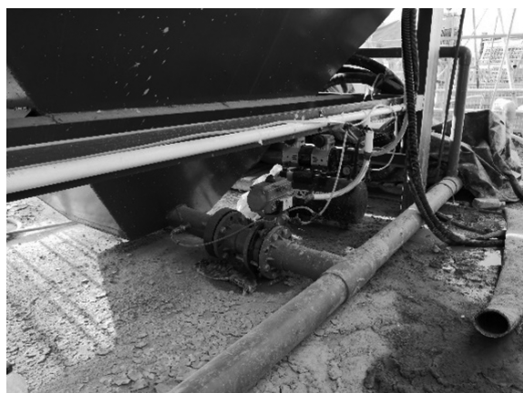
图 11 絮凝沉淀池、反应槽底泥浆管路布置
