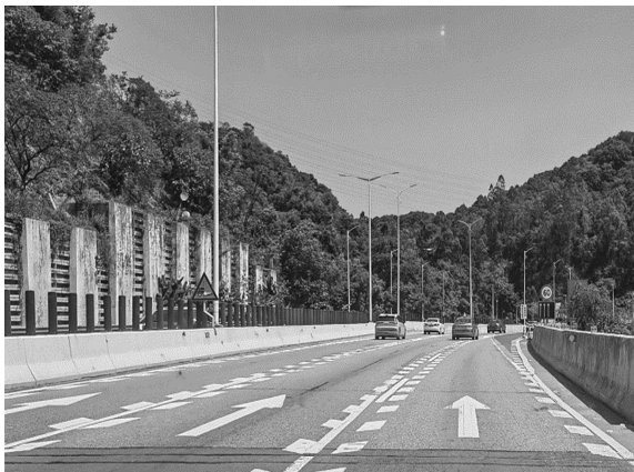
图 2 注浆处治施工后回访路面情况
