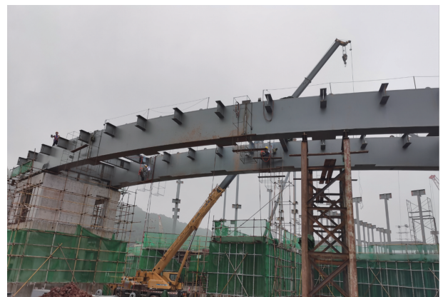
图 6 钢箱梁吊装拼接现场
