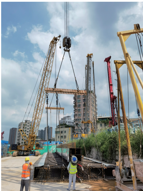
图 10 “T”型钢筋笼起吊
