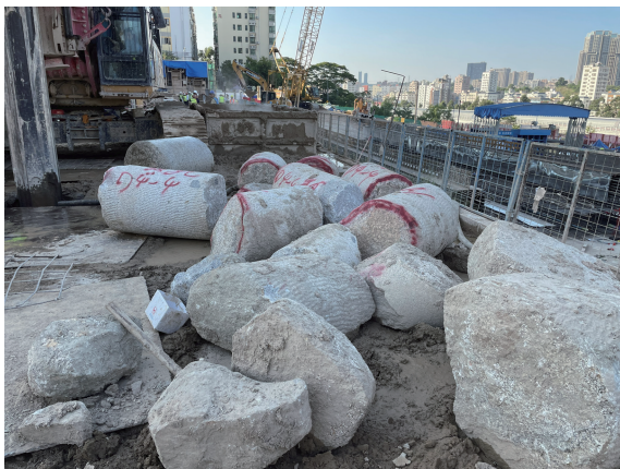
图7 旋挖机破碎后孤石
