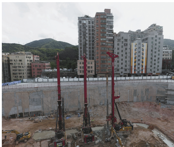
图15 开挖完成后现场
