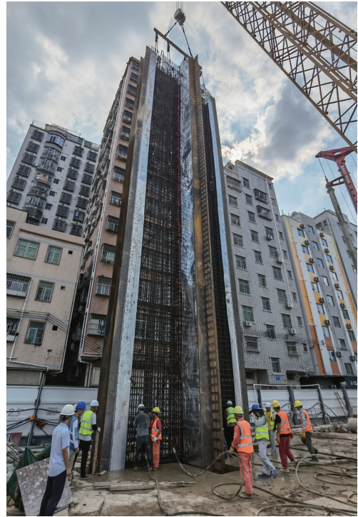
图 11 “T”型钢筋笼入槽段
