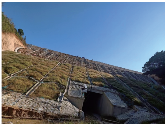
图12 修筑完工后的临沧站场高边坡
