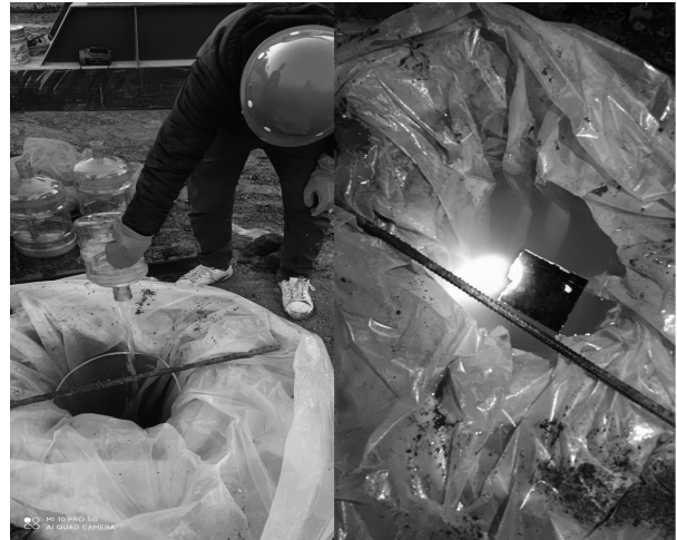
图2 桩孔注水过程
