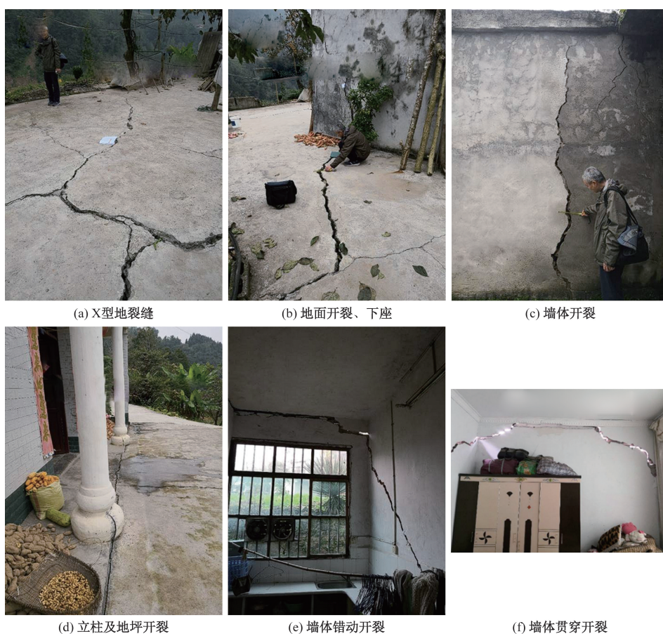
图4 滑坡变形破坏情况
