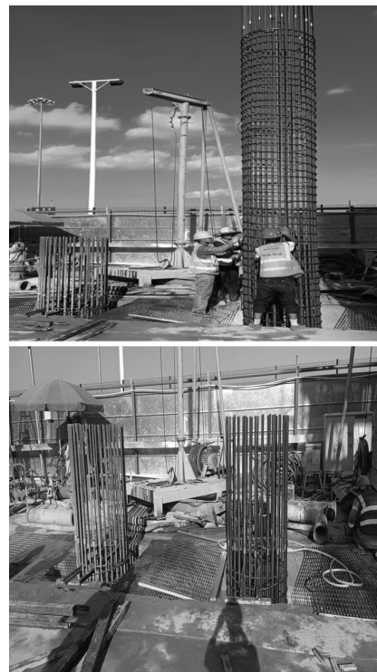
图 10 灌注桩钢筋笼槽口定位
