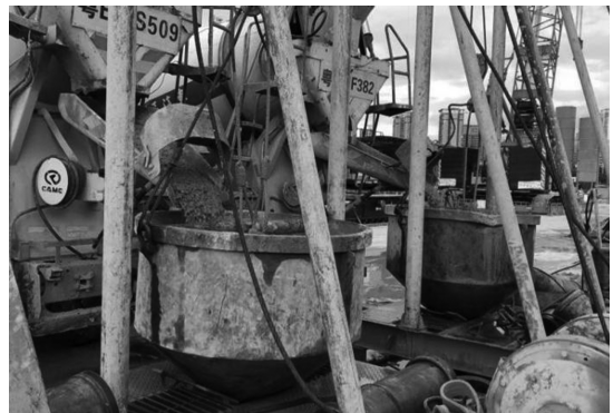
图 14 桩墙混凝土灌注
