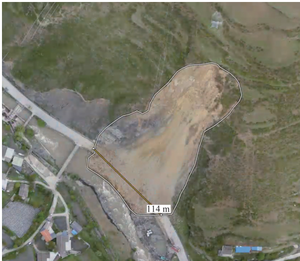
图5 2#滑坡高精度倾斜模型损毁道路长度实测
