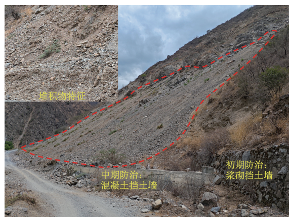
图 2 崩坡积堆积体全貌特征
