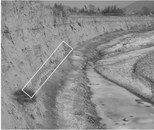
图3 黄土边坡坡脚可溶盐析出
