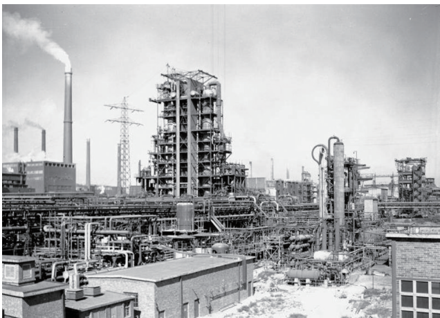
19世纪20年代德国工厂率先采用费托法生产液体燃料
