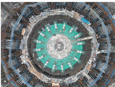
BEST首个关键部件杜瓦底座成功安装就位。 杜瓦底座是国内聚变领域最大的真空部件, 将用来承载总重约6700 t的BEST主机 (图片来源:中国建筑集团有限公司)
