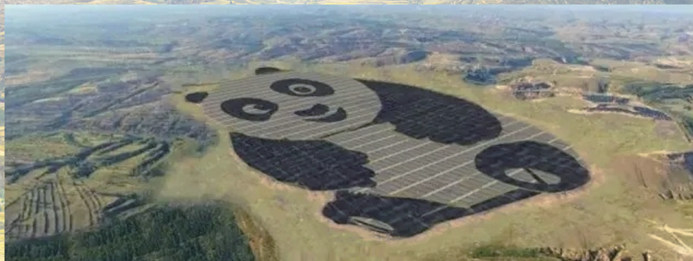
大同矿区熊猫电站（黑色部分是单晶硅太阳能电池，白色部分为薄膜太阳能电池）
