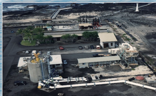
210 kW 夏威夷海洋温差能转换实验电厂
