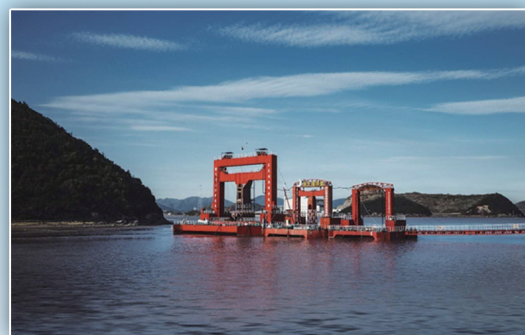
浙江大学漂浮式潮流能发电装置
