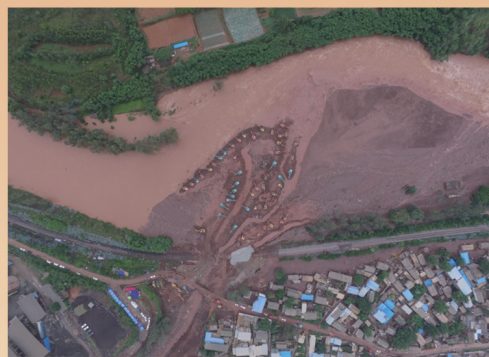
2016年9月，云南省楚雄州元谋县布善沟泥石流冲毁成昆铁路线路200余米
