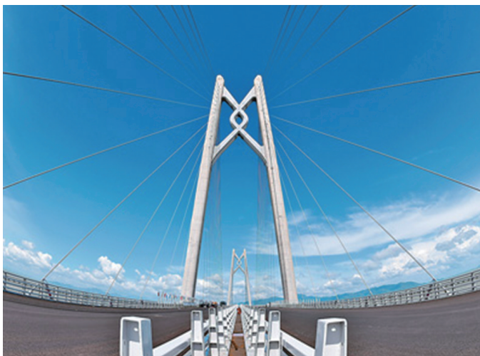
港珠澳大桥上的“中国结”造型桥塔(图片来源:新华社/梁旭)
