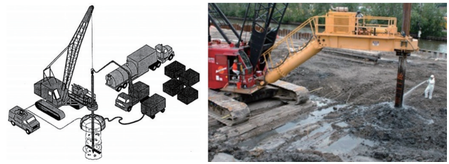
图3 原位S/S设备及示意
