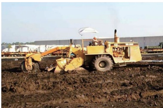
图2 原位区块式S/S设备
