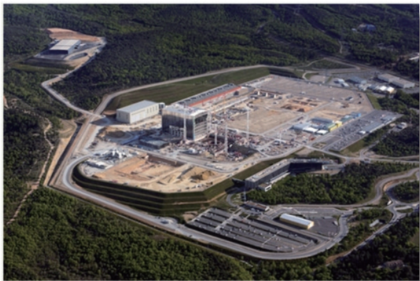
正在施工中的ITER项目
