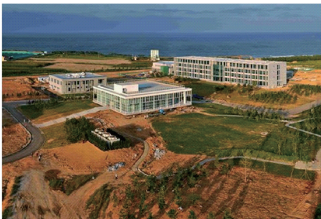
华能山东石岛湾高温气冷堆(图片来源:澎湃新闻)
