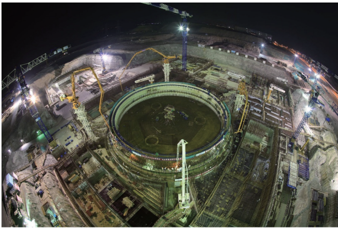
“华龙一号”5号机组(图片来源:中国核电工程有限公司)
