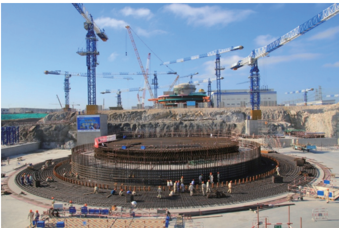
“华龙一号”在建图(图片来源:中国核电工程有限公司)
