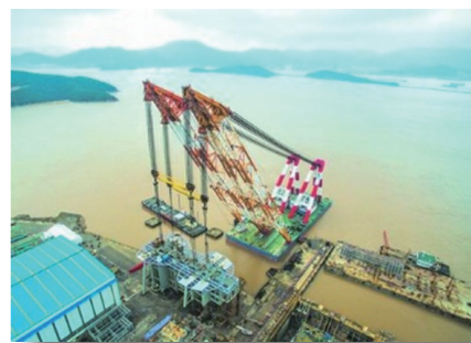
发电机组的总成平台由吊装船吊装下海 (图片来源:新华社)
