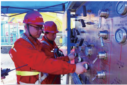
施工人员正在“压裂井工厂”平台调试页岩气关键技术——泵送桥塞与多级射孔联作技术设备装置。
