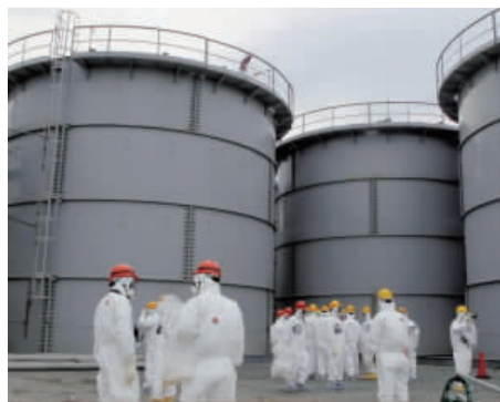
福岛核电站核泄漏事故发生后,东电建造了约1000座储水罐来存放冷却反应堆的放射性污水。图片来源:路透社
