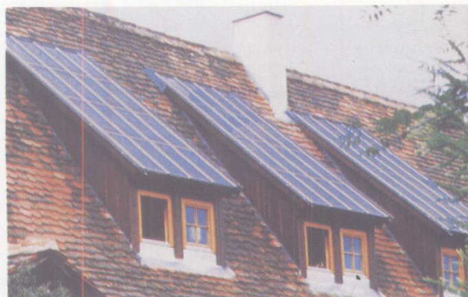
装在无遮楼顶上的光伏设备(2.4千瓦)
