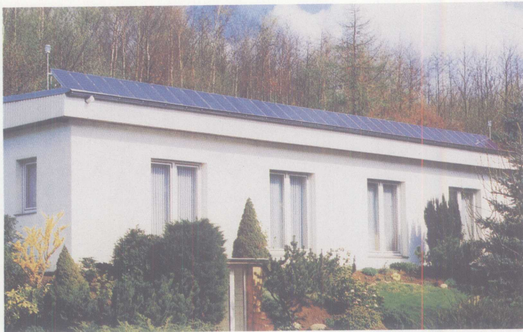
架于平房上的光伏设备(1.8千瓦)
