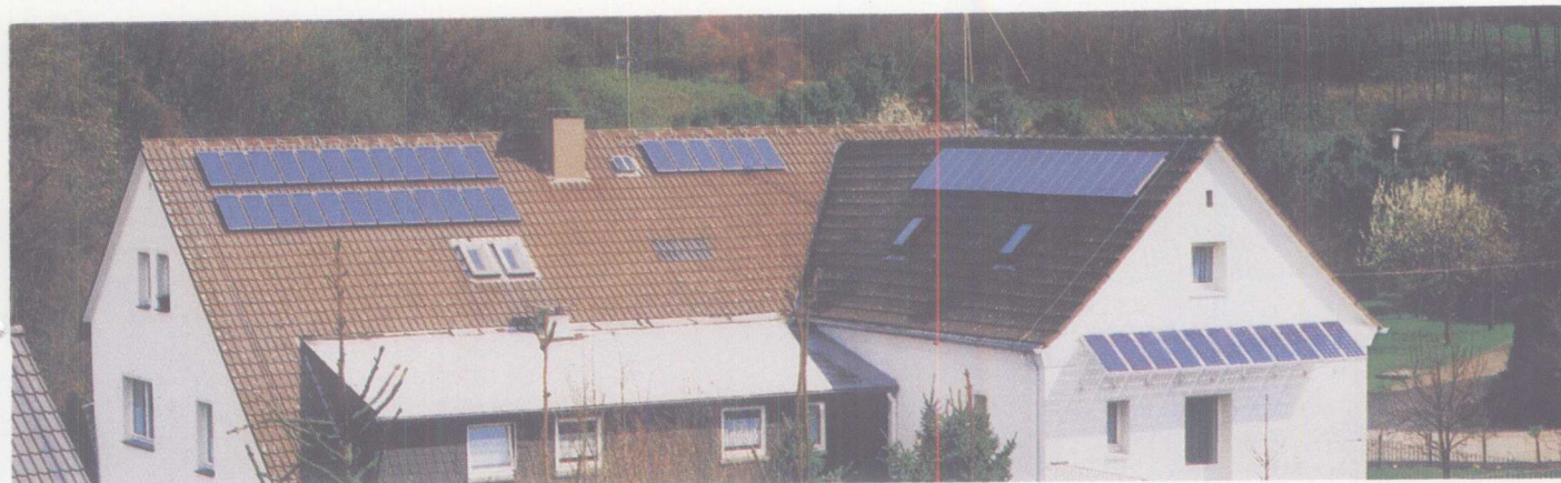
朝向不同的太阳电池阵(2.7千瓦)
