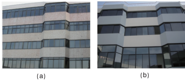
图3 模型建筑节能改造前(a)、后(b)照片
