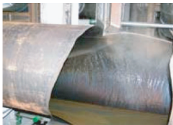
图 2 流体加速腐蚀引起的管道失效
